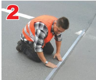
Die Ränder der zu reparierenden Fläche können mit "Steinklebeband" abgeklebt werden, um ein saubereres Endbild zu erzielen. (Bild 2). Anschließend wird die zu reparierende Fläche mit einem Quast leicht vorgehässt um einen besseren Verbund zum Untergrund zu erhalten (Bild 3).
