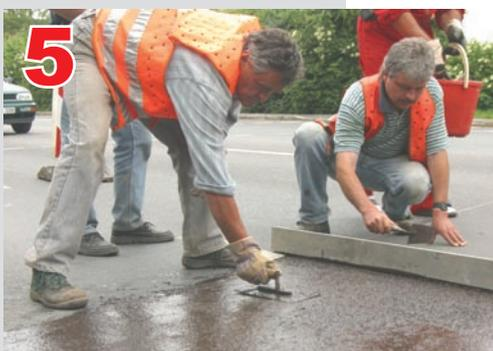
Nach dem Anmischen muss die Mischung zügig aufgetragen, verdichtet und geglättet werden. Je nach Witterung ist die reparierte Fläche bereits nach 30 min. belastbar (Bild 5).
