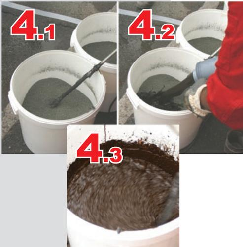
Der Edelsplitt wird zunächst unter Zugabe des Beschleunigerpulvers mit einem Rührgerät trocken durchmischt (Bild 4.1). Anschließend wird Wasser zugegeben, bis die Masse die Konsistenz eines erdfeuchten Betons hat. Zum Schluss die Bitumenemulsion hinzugeben und solange durchmischen, bis eine homogene Mischung entsteht (Bild 4.3). Bei höheren Temperaturen kann etwas mehr Wasser der Mischung beigegeben werden.
