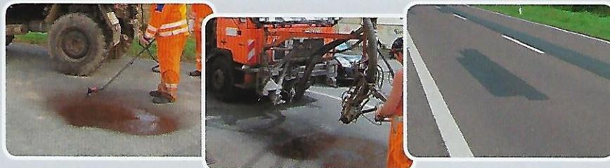
**BORNIT®-Emulsion au bitume C60B5-REP** - Emulsion au bitume à comportement de rupture et de prise rapide en contact avec gravillons nobles, sans solvants. Répandre des gravillons nobles adaptés immédiatement après la pose, en fonction de l'utilisation.
