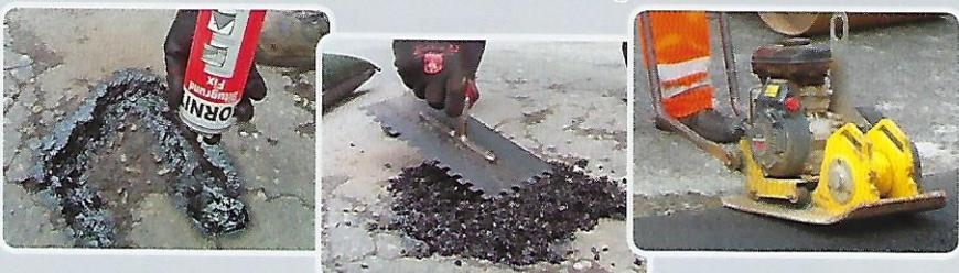
**BORNIT®-Anti nids de poule** - Matériau de réparation à utiliser à froid pour les routes en asphalte; compactage ultérieur par des véhicules en circulation absolument obligatoire; non adapté pour des surfaces de stationnement, les entrées et voies d'accès ainsi que les trottoirs et pistes cyclables.
