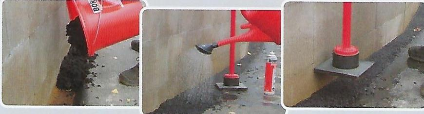
**BORNIT®-Réactif Asphalt 40 / 80** - Granulat réactif à l'eau, durcissant à froid, épaisseurs de couches jusqu'à 50 mm, possibilité de circuler immédiatement sur les endroits réparés après la pose et le compactage; pas de compactage ultérieur nécessaire par le trafic en circulation – parfaitement adapté pour des réparations dans des entrées, trottoirs et parkings.
