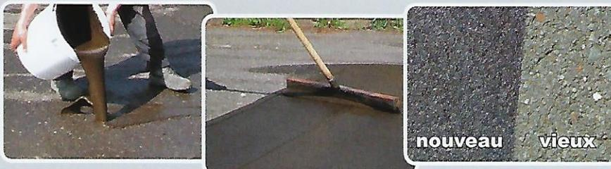
**BORNIT®-Boues prêtes à l'emploi** - Boues de bitume prêtes à l'emploi, sans solvants, avec des matériaux de remplissage minéraux, faciles à utiliser, à séchage rapide.
