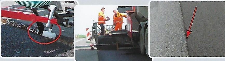
**BORNIT®-Nahtflex®** - Masse en bitume ultra-flexible, stable, sans solvants, utilisable jusqu'à -5°C; application rapide et mécanique avec le **BORNIT®-Flexomat 3.0**.
