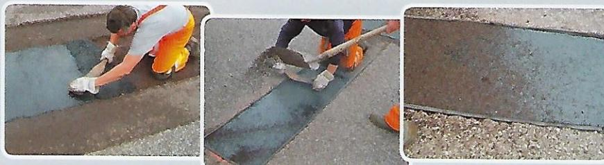
**BORNIT®-Asphalte coulé** - masse de réparation à utiliser à chaud; emploi avec des épaisseurs de couches jusqu'à 30 mm, possibilité de circuler directement après le refroidissement, pas besoin de compactage ultérieur par le trafic en circulation.
