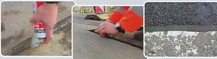
**BORNIT®-Bande de joints** - Bande de joints flexible et à fondre en bitume polymère modifié, haut pouvoir autocollant, en combinaison avec le **BORNIT®-Easy-Primer FB**, la bande de joints adhère très bien aux surfaces des flancs, même sans flambage.
