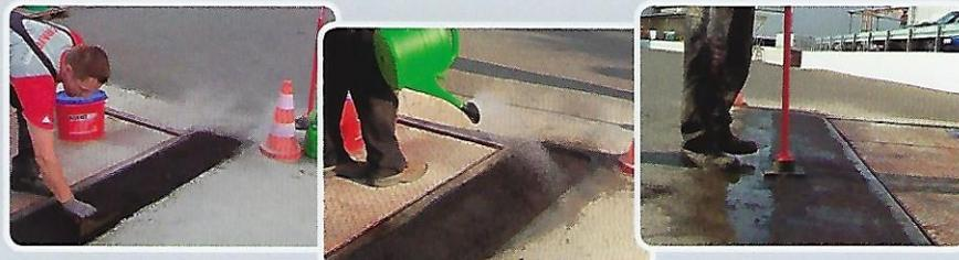
**BORNIT®-Réactif Asphalte 20** - Granulat réactif à l'eau, durcissant à froid, les véhicules peuvent circuler sur les endroits réparés immédiatement après la pose et le compactage; pas de compactage ultérieur nécessaire par le trafic en circulation – parfaitement adapté pour des réparations dans des entrées, trottoirs et parkings.
