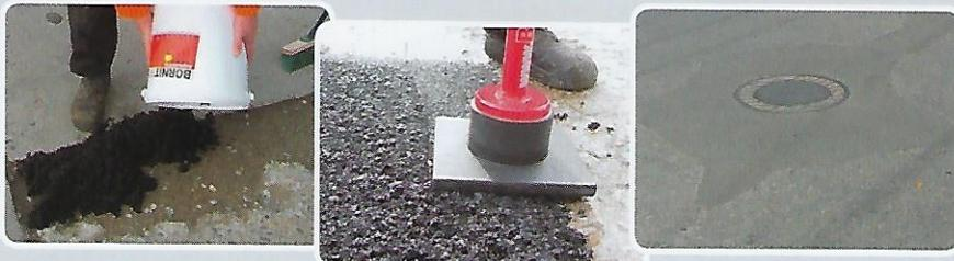
**BORNIT®-Asphalt-Fix** - Granulat à froid, utilisable pour jusqu'à max. 50 mm d'épaisseur de couche, compactage ultérieur par des véhicules en circulation absolument obligatoire, une fois durci, il possède les mêmes propriétés d'utilisation que les granulats à chaud.
