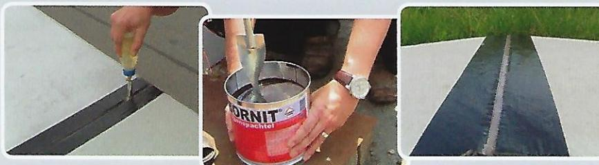
**BORNIT®-Scellement à froid / BORNIT®-Enduit à joints** - Produits de remplissage de joints en polysulfure à 2 composants, résistant aux influences météorologiques et au vieillissement; **BORNIT®-scellement à froid** (auto-nivellement) pour des joints horizontaux resp. **BORNIT®-enduit à joints** (stable) pour joints verticaux et joints en pente. Couche de fond avec **BORNIT®-Béton** ou **Asphaltprimer**.
