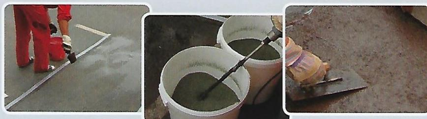
**BORNIT®-Mortier de réparation RE 30 / RE 50** - Masse de réparation à séchage rapide et à 3 composants, les véhicules peuvent déjà circuler au bout de 30 minutes.
